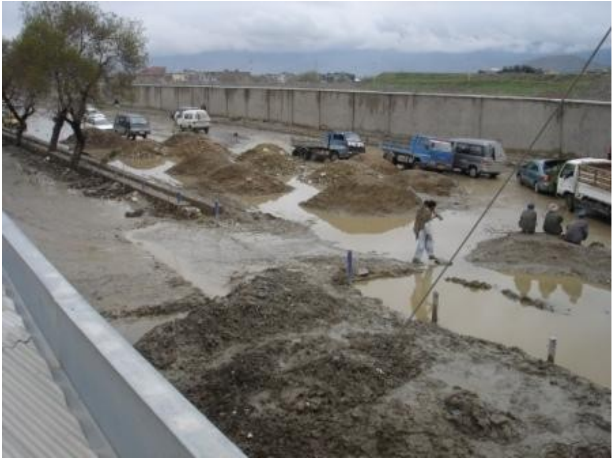
Die Einfahrt zum Hospital ist eine einzige Baustelle...
